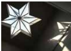
▲階段室天井の六稜窓
